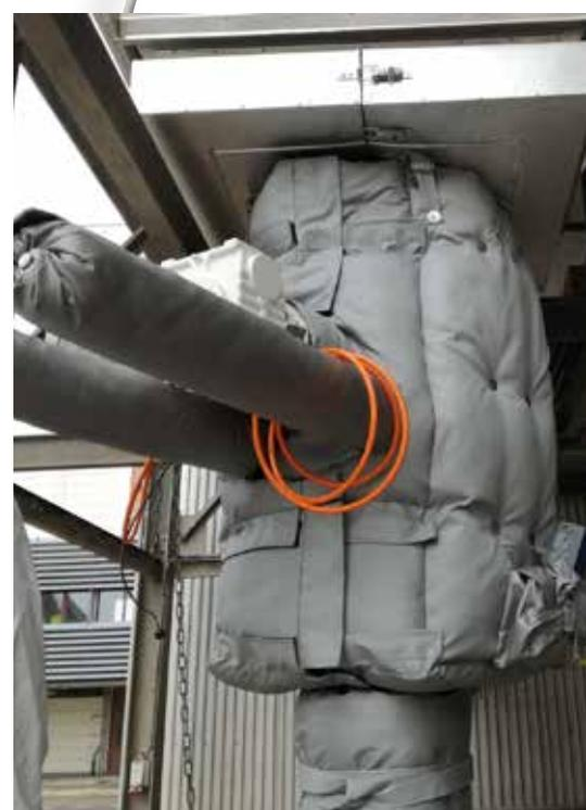
Ottimizzato per operare in parti di impianto con temperature particolarmente basse, funge principalmente quale strumento antigelo. Questa funzione è strettamente necessaria per mantenere i liquidi nel loro stato fisico e per controllarne la viscosità; va anche aggiunto che il passaggio di liquidi densi come oli, cere e cioccolato, richiede un loro riscaldamento per garantirne una corretta conservazione.
